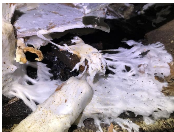
Ett angrepp av rötskadesvamp, troligtvis hussvamp, påträffades i kulverten.
