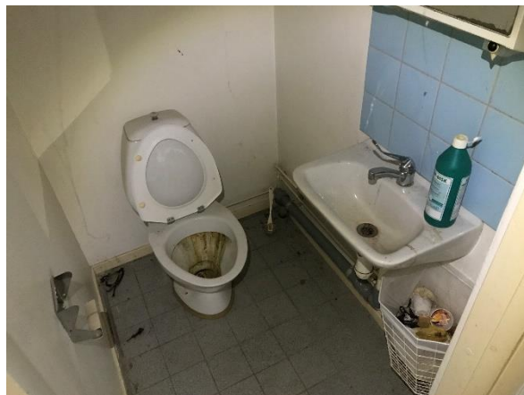
Toalett och våtutrymmen där asbest kan finnas i fogen eller fästbruket bakom kakel och klinkers.
