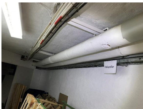
Värmeledningar i kulvert som sannolikt är isolerad med asbesthaltigt material.
