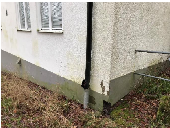
Sättningsskador vid knuten mot baksidan av huset. Här syns tydligt fasadens innehåll av blåbetong.
