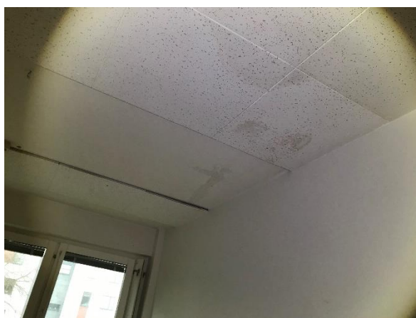
Takläckage som orsakat mikrobiella skador och uppkomst av någon svampart.
