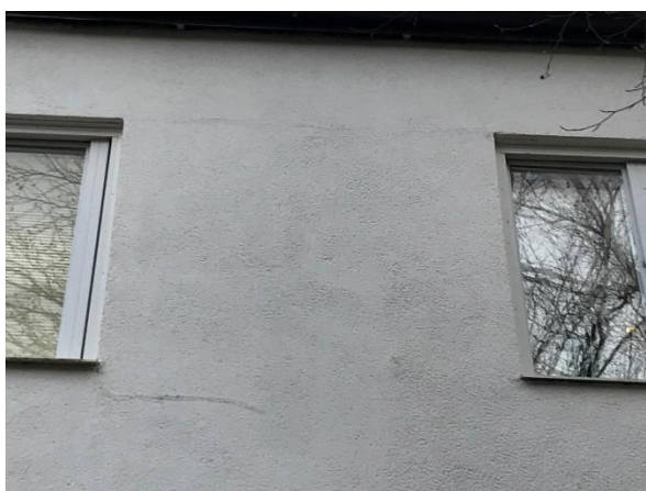
En utbredd skada i anslutning till fönstren är diagonala sprickor från fönsterbleckens gavlar. Detta återfinns vid ett flertal fönster.
