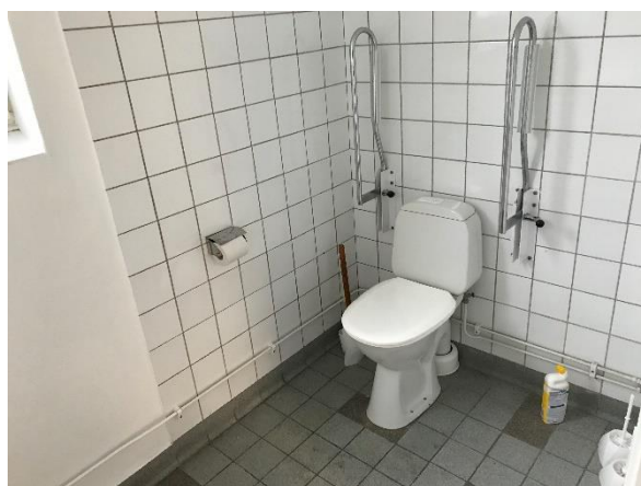
Toalett och våtutrymmen där asbest kan finnas i fogen eller fästbruk bakom kakel och klinkers.
