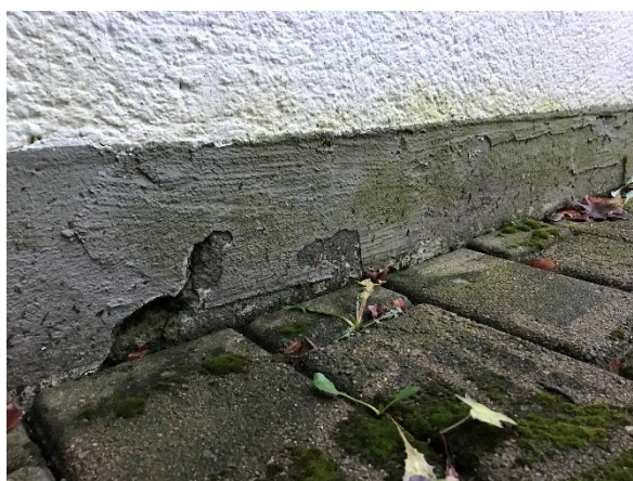
Sättningskador som har orsakat sprickor i vägg och håligheter under bottenplattan vid gaveln mot framsidan av huset.
