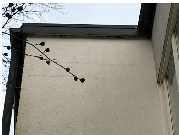
Sprickor i fasaden vid gaveln som vetter mot parkeringen.
