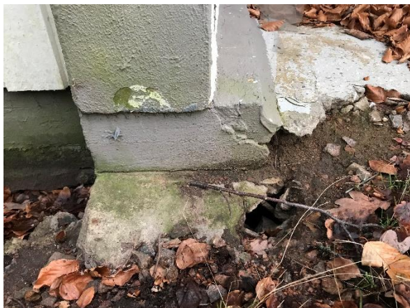
Sättningskador som har orsakat sprickor i vägg och håligheter under bottenplattan vid baksidan av huset.
