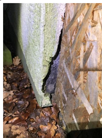
Dokumentation av förekomst av blåbetong. Gamma mätaren ger utslag på 0,48 och gränsvärdet för indikation av blåbetong ligger på 0,35.
