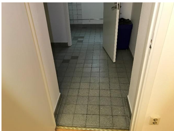
Toalett och våtutrymmen där asbest kan finnas i fogen eller fästbruket bakom kakel och klinkers.
