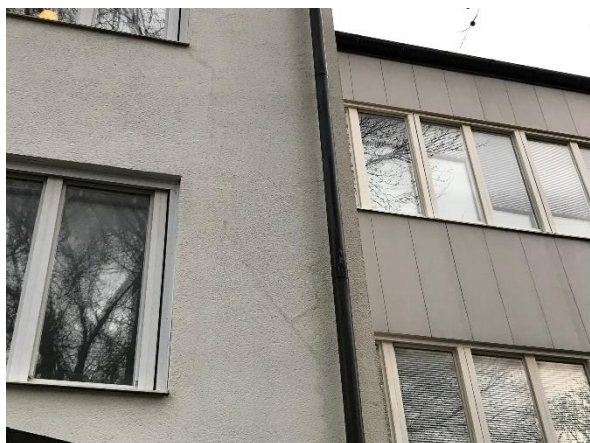
Sprickskador i fasaden längs långsidan mot parkeringen.
