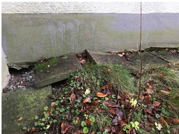
Sättningskador som har orsakat sprickor i vägg och håligheter under bottenplattan vid baksidan av huset.
