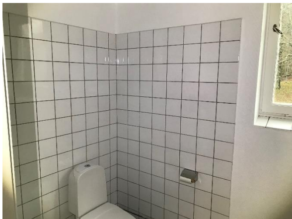
Toalett och våtutrymmen där asbest kan finnas i fogen eller fästbruket bakom kakel och klinkers.
