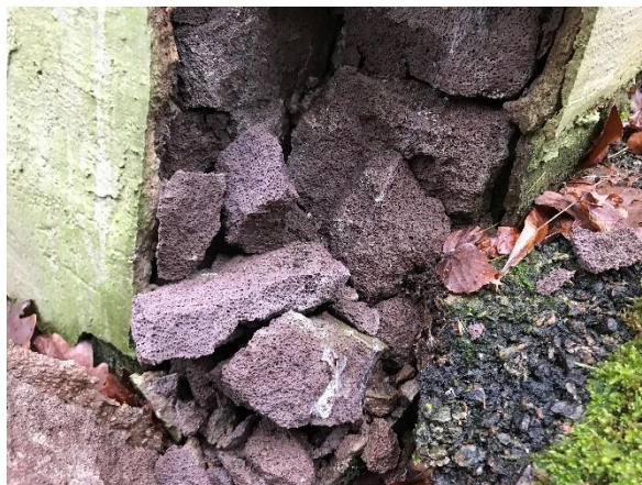
Sättningsskador vid knuten mot baksidan av huset. Här syns tydligt fasadens innehåll av blåbetong.
