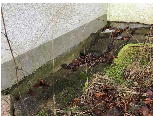
Sättningskador som har orsakat sprickor i vägg och håligheter under bottenplattan vid gaveln mot framsidan av huset.
