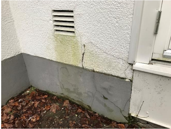
Sättningskador vid sockel samt sprickskador i fasaden ovan entrén.
