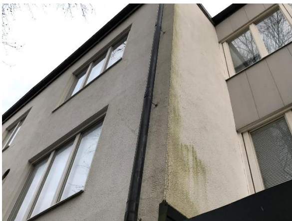
Sprickskador i fasaden ovan entrén till parkeringen samt diagonal spricka i fasaden vid gaveln på baksidan huset.
