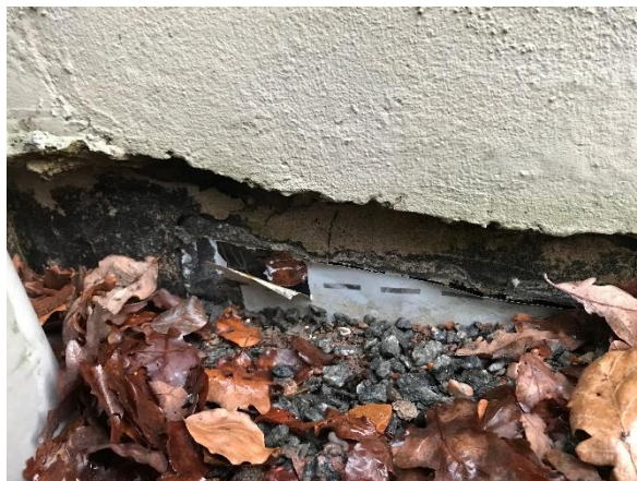
Sättningskador som har orsakat sprickor i vägg och håligheter under bottenplattan vid baksidan av huset.
