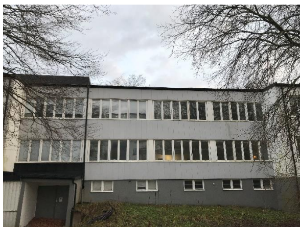
Ett parti av fasaden på baksidan av huset är täckt av eternitskivor som är reglade med tryckimpregnerat trä.
