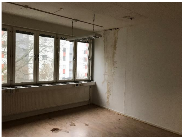
Takläckage som orsakat mikrobiella skador och uppkomst av någon svampart.
