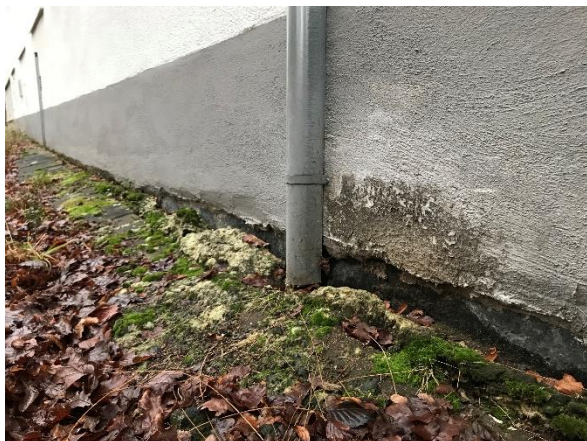
Sprickskador och putssläpp vid suterrängdelen av huset.
