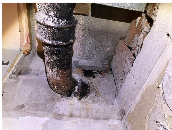
Äldre gjutjärnsledningar är ingjutna i bottenplattan.
