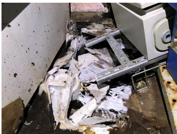
Ett angrepp av rötskadesvamp, troligtvis hussvamp, påträffades i kulverten.
