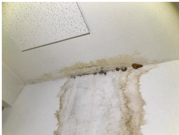
Takläckage som orsakat mikrobiella skador och uppkomst av någon svampart.
