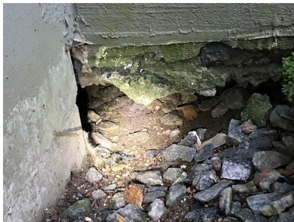
Sättningskador som har orsakat sprickor i vägg och håligheter under bottenplattan vid baksidan av huset.
