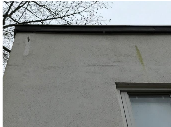
Lodrät spricka i fasad samt sprickskador vid takfot vid baksidan av huset.
