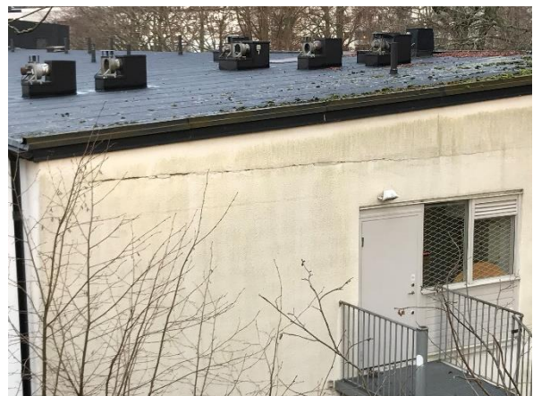
Sprickskador i fasaden ovan entrén till parkeringen samt diagonal spricka i fasaden vid gaveln på baksidan huset.
