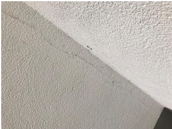
Lodrät spricka i fasad samt sprickskador vid takfot vid baksidan av huset.
