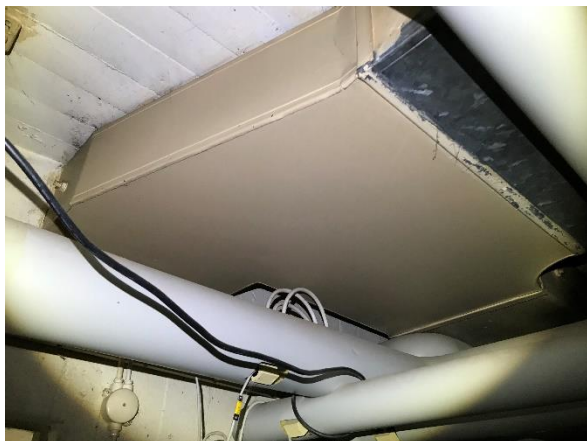
Äldre ventilationskanaler där asbesthaltigt kitt kan finnas.
