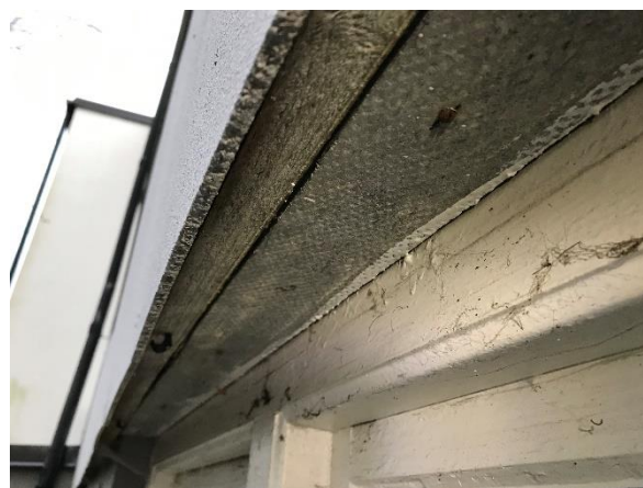
Ett parti av fasaden på baksidan av huset är täckt av eternitskivor som är reglade med tryckimpregnerat trä.
