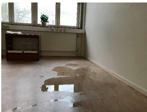
Läckage från tak och fönster av utifrån kommande vatten.
