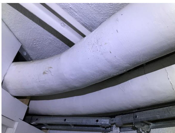
Värmeledningar i kulvert som sannolikt är isolerad med asbesthaltigt material.
