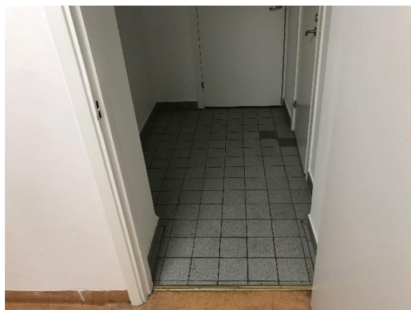
Toalett och våtutrymmen där asbest kan finnas i fogen eller fästbruket bakom kakel och klinkers.
