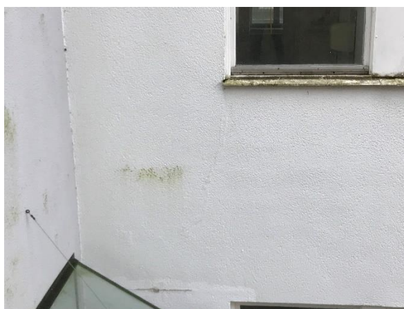
En utbredd skada i anslutning till fönstren är diagonala sprickor från fönsterbleckens gavlar. Detta återfinns vid ett flertal fönster.
