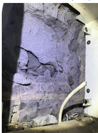
Dokumentation av förekomst av blåbetong. Gamma mätaren ger utslag på 0,48 och gränsvärdet för indikation av blåbetong ligger på 0,35.
